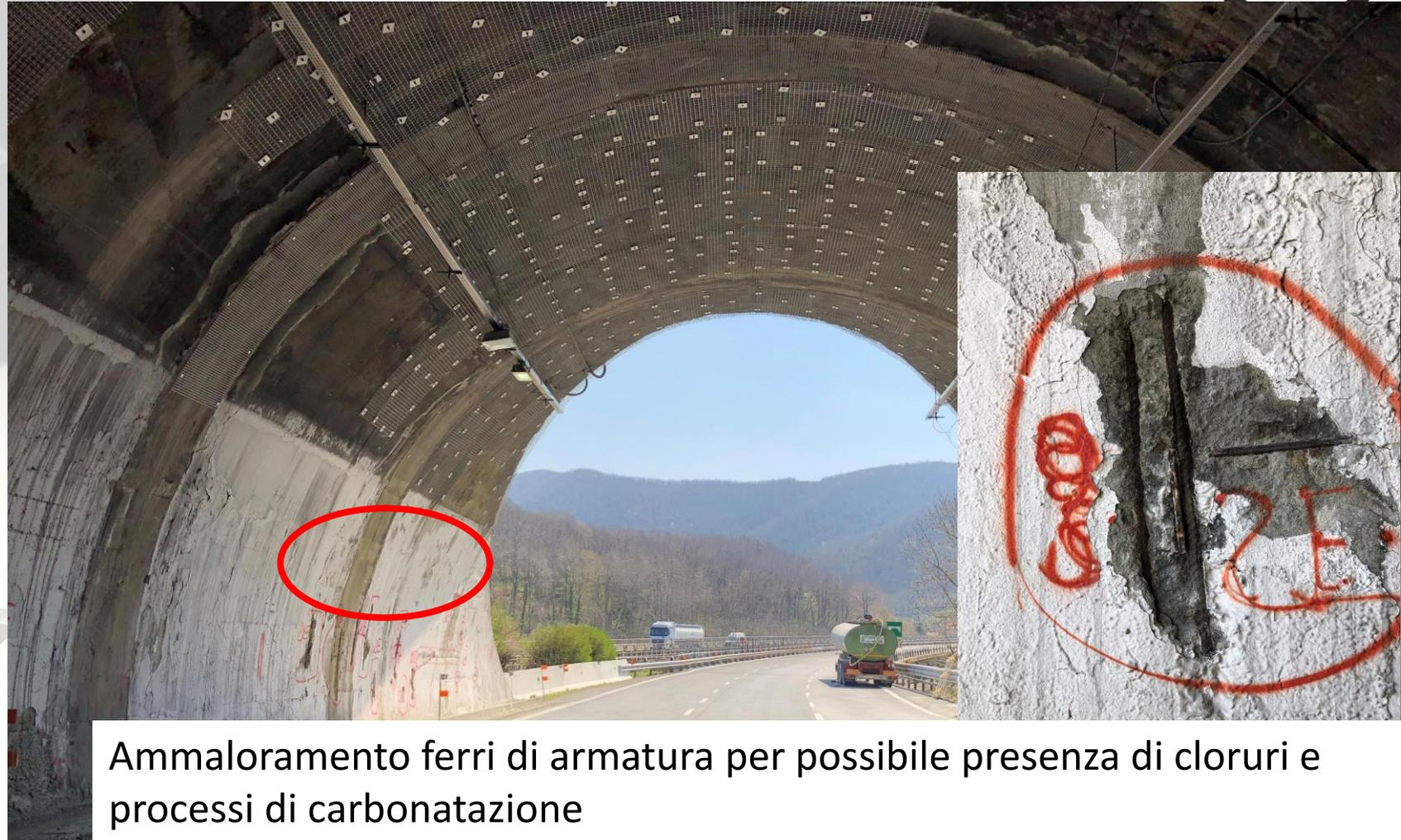
Ammaloramento ferri di armatura per possibile presenza di cloruri e processi di carbonatazione
