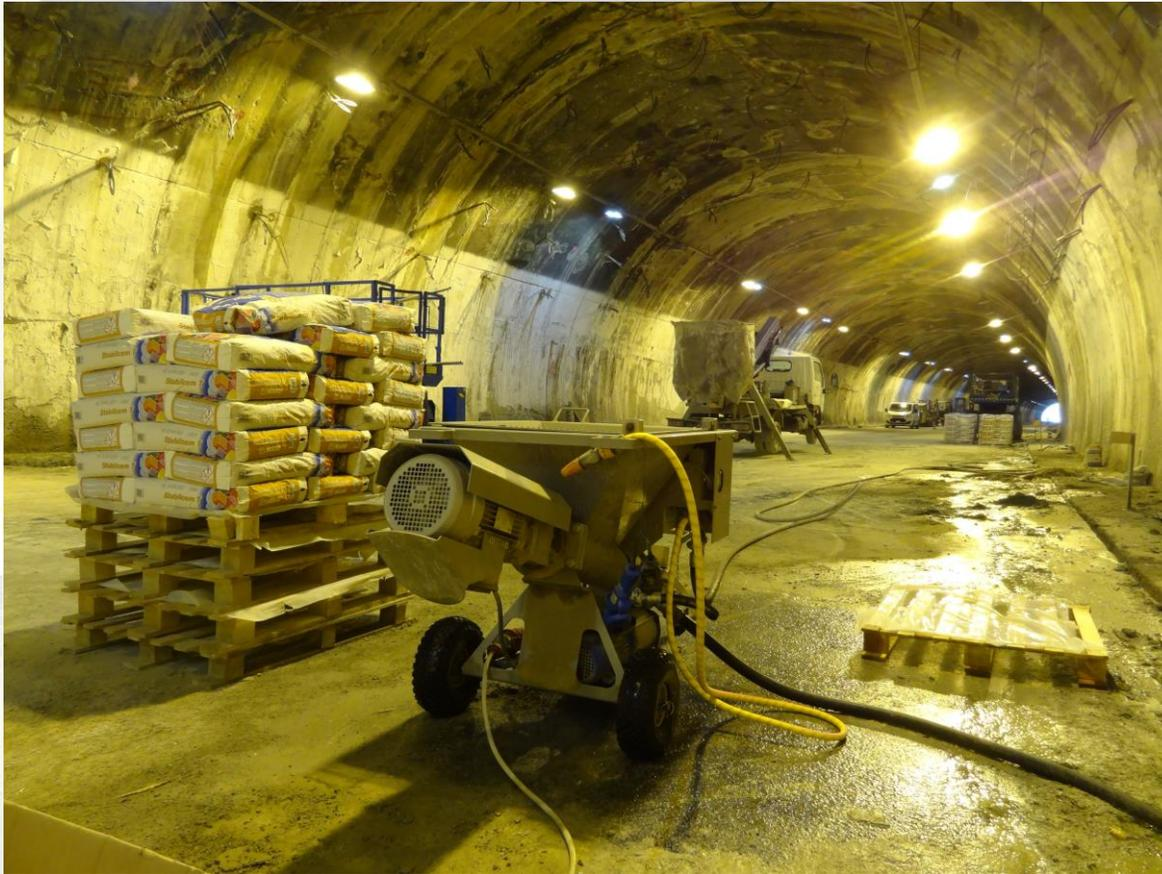
Iniezione di malta tissotropica con pompa a miscelazione continua
